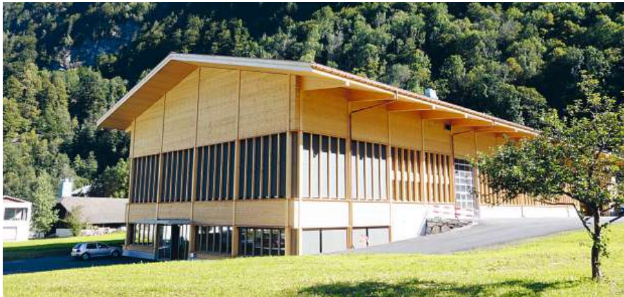
Die neue Produktionshalle der Marti AG Holzbau, Matt
