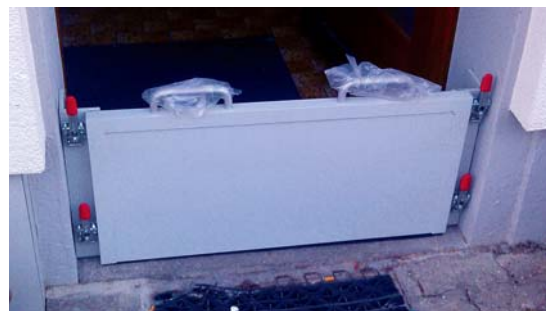
Temporäre Objektschutzmassnahme gegen Hochwasser
