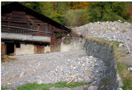
Überführung durch die Sturmigerrunse im Ennetrösligen in Ennenda
